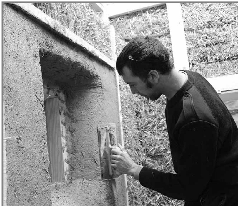
Réalisation d'un enduit à base de paille, terre et sable, sur une maquette à taille réelle.
