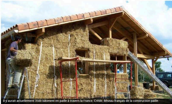
Il y aurait actuellement 3500 bâtiments en paille à travers la France. Crédit: Réseau français de la construction paille.
