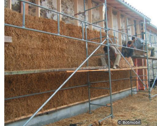
L'isolation thermique par l'extérieur permet d'isoler, a posteriori, un bâtiment déjà construit. Les bottes de paille sont fixées au mur existant ou sont insérées dans une ossature secondaire elle-même fixée au mur existant.
