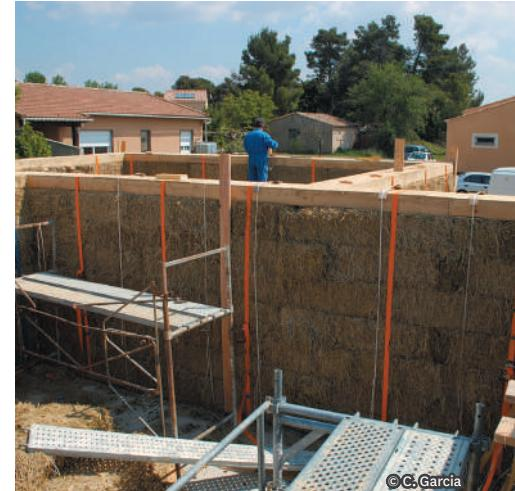
La botte de paille a ici un rôle structurel en plus d'être un isolant thermique. Il n'y a pas d'ossature bois, ce sont les bottes de paille qui portent la charpente.
