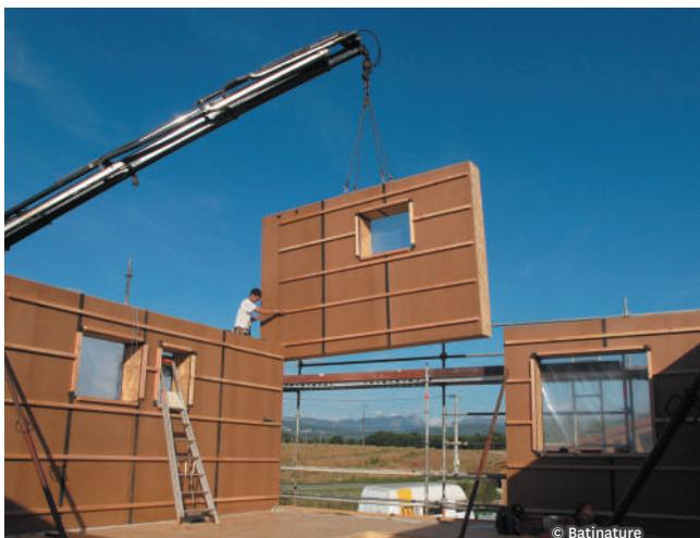
Technique la plus répandue en terme de surface bâtie, le principe est de fabriquer en atelier des caissons isolés et équipés. Le bâtiment peut ensuite être levé très rapidement, quelques jours pour une habitation, quelques semaines pour les grands bâtiments. Ces caissons sont porteurs ou viennent combler des structures bois, métal ou béton.
