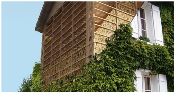
Figure 6 : Maison Feuillet, plus ancienne maison en ossature bois et remplissage paille connue à ce jour (Conseil départemental du Loiret, 2020)
