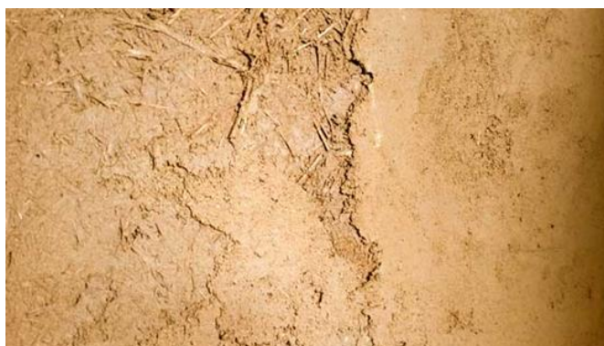
Figure 3 : Enduit de terre crue sur paille
