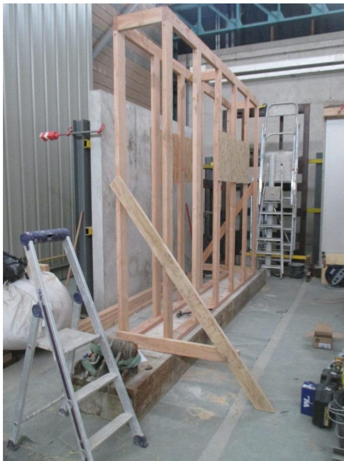
Photographie 4 : maintien des montants verticaux avec feuilards
