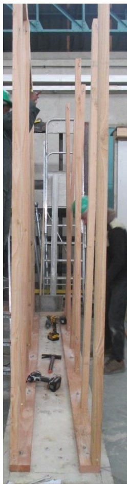
Photographie 4 : maintien des montants verticaux avec feuilards
