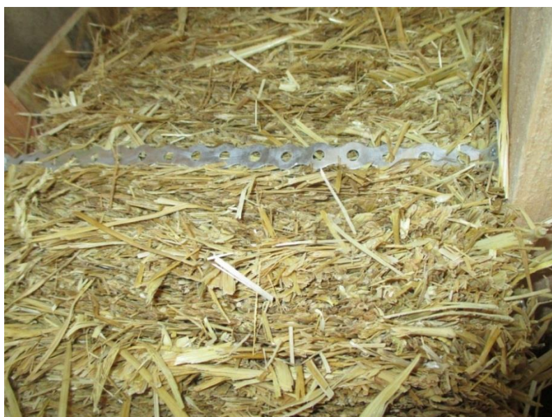
Photographie 4 : maintien des montants verticaux avec feuilards
