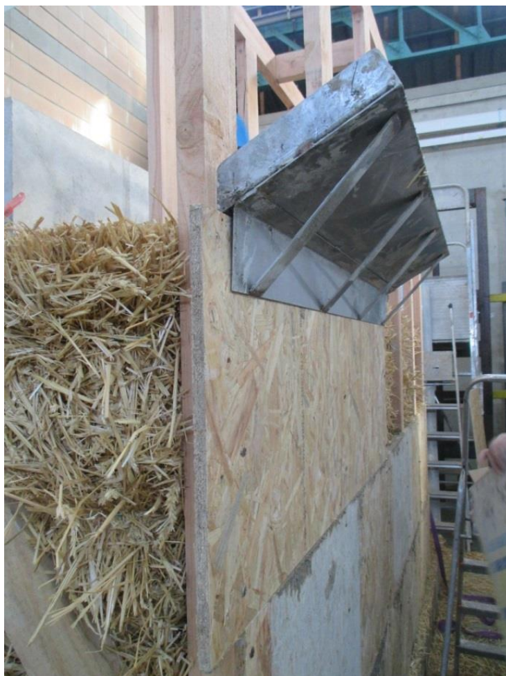
Photographie 6 : coffrage en planche OSB et coulage du mortier
