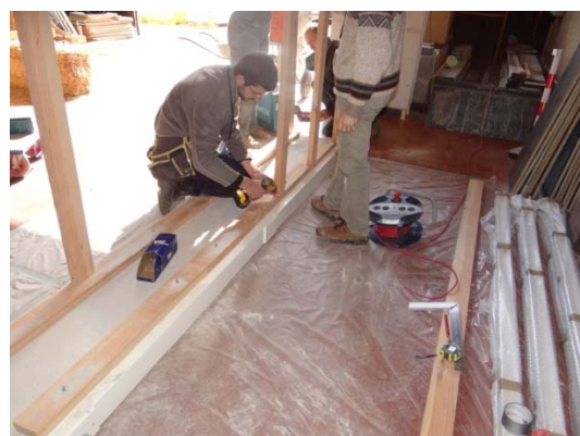
Fixation des poteaux
