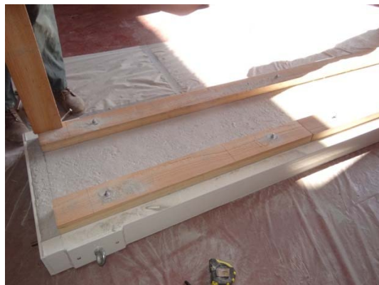
Fixation des lisses basses
