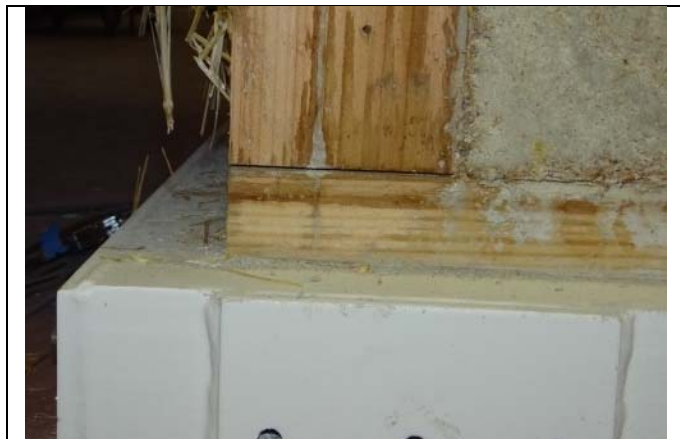
Figure 15 : Photographie de la liaison poteau/lisse
