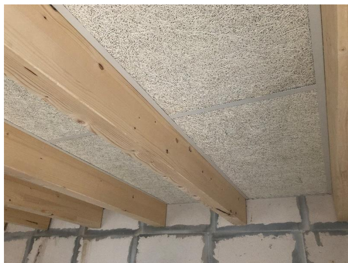
Figure 20 – Photos de l'installation du faux-plafond
