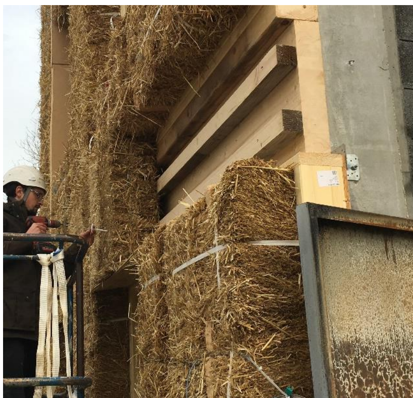
Figure 7 - Photos de l'installation des bottes de paille sur la muralière
