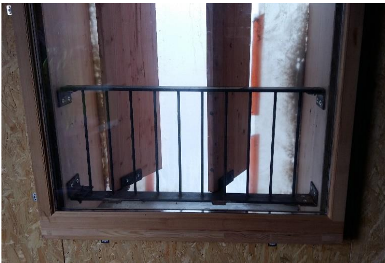
Figure 13 – Photos du garde-corps et des brise-soleils sur la Baie 2'
