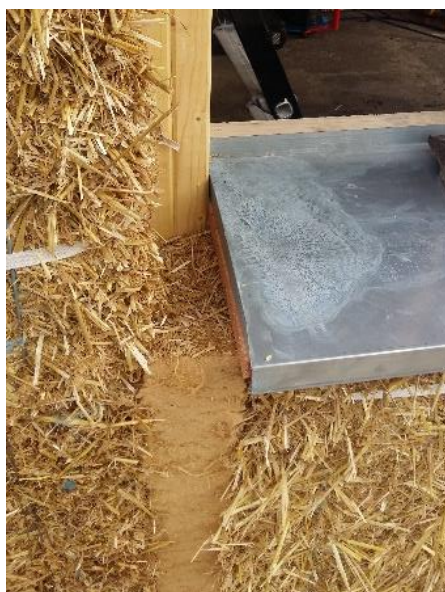
Figure 9 - Photos de l'installation d'une tôle de rejet d'eau
