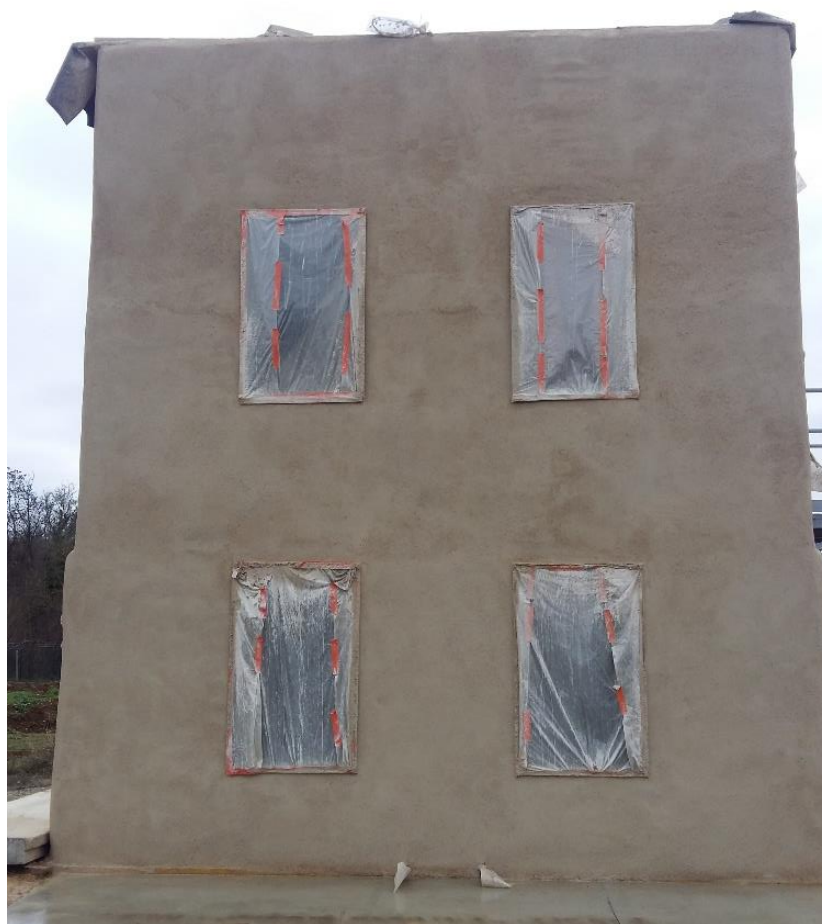
Figure 16 – Photo de la façade après mise en œuvre de l'enduit
