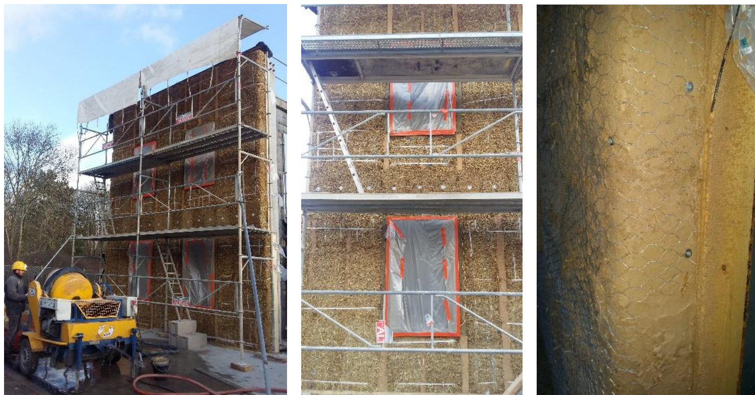
Figure 15 – Photos de la façade avant mise en œuvre de l'enduit
