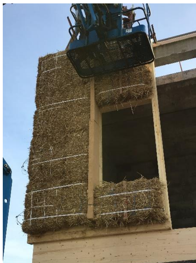
Figure 1 – Photos du panneau MOB 0-2 et de son installation
