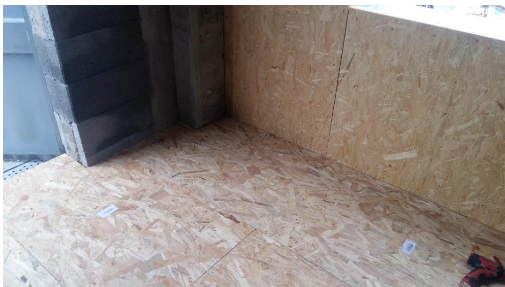
Figure 6 - Photos des panneaux en bois du plancher
