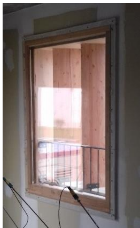
Figure 22 - Photos des cadres en plaques de plâtre en périphérie des fenêtres des Bais 1' et 2'
