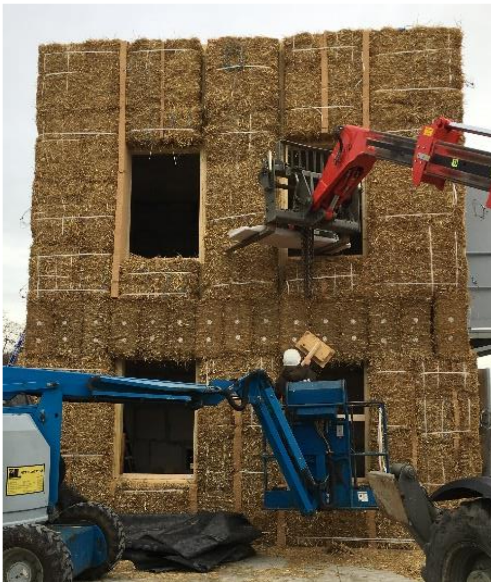
Figure 8 - Photo de la façade en paille et du rattrapage de la planéité des bottes de paille à l'aide d'un persuadeur
