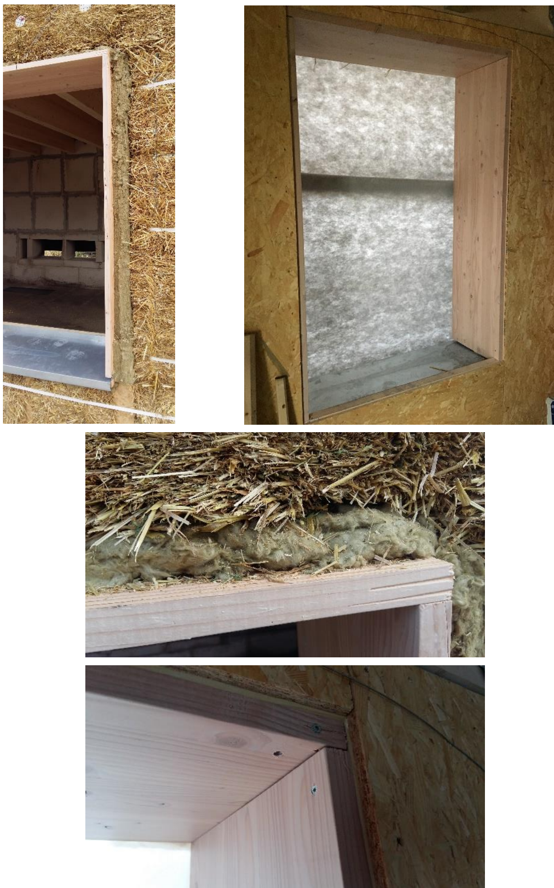
Figure 12 - Photos de la fixation de l'encadrement en bois et de la laine de roche en périphérie de la Baie 2
