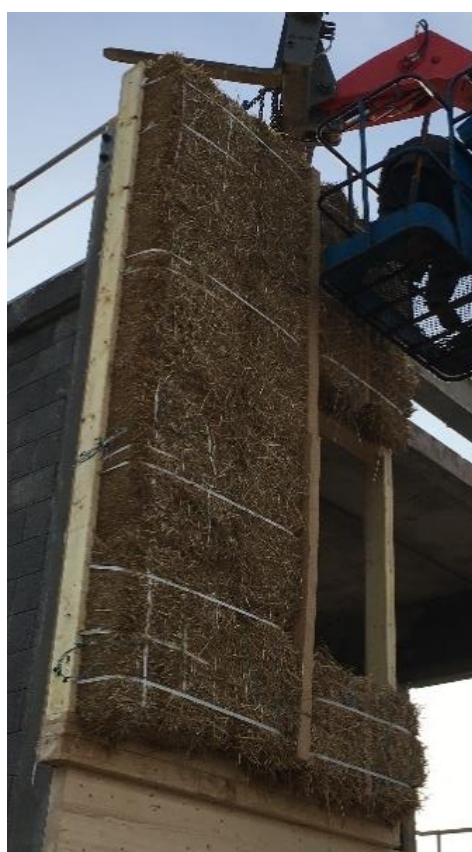
Figure 1 – Photos du panneau MOB 0-2 et de son installation
