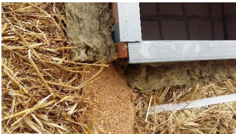
Figure 11 - Photos de l'installation de la finition en tôle sur l'encadrement en bois et de la laine de roche en périphérie de la Baie 1
