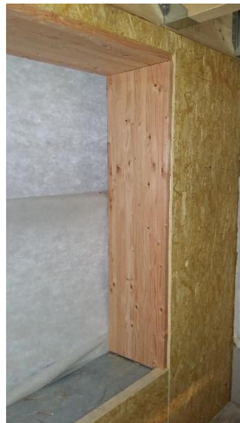
Figure 10 - Photos de l'installation des encadrements des Baies 1 et 2
