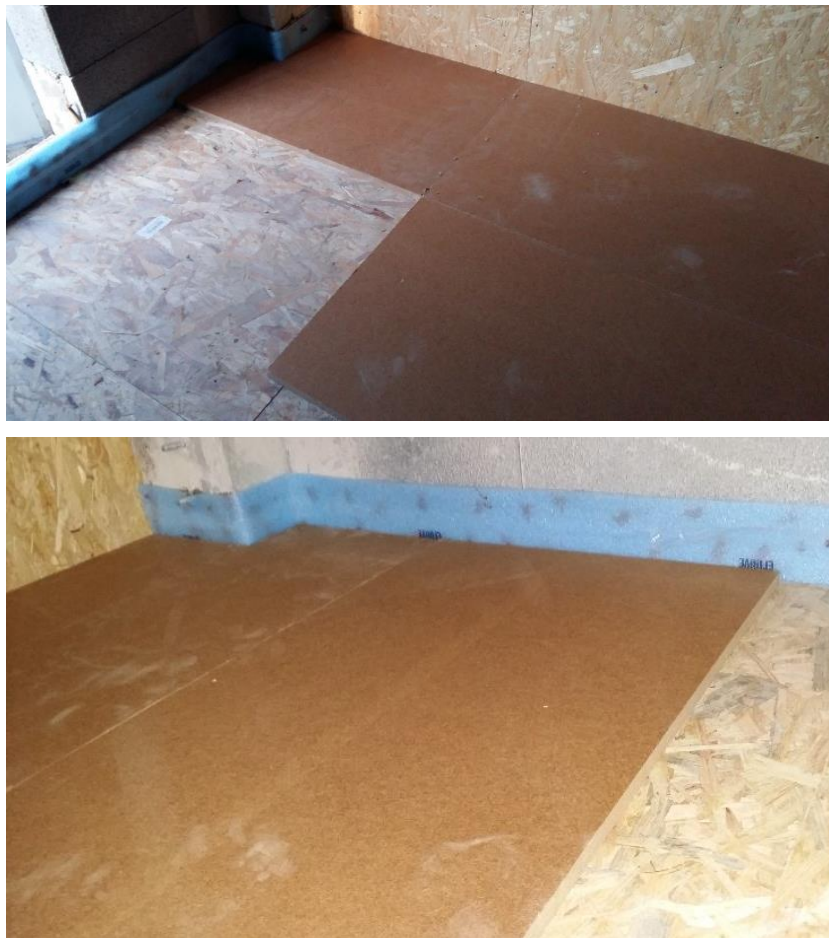
Figure 17 – Photos de la pose de l'isolant acoustique du plancher
