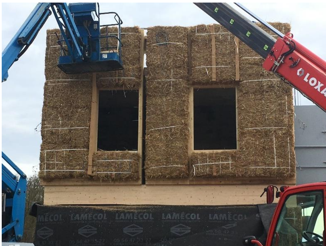
Figure 3 - Photo de la mise en place des panneaux MOB 0-2, MOB 0-3 et MOB 0-4
