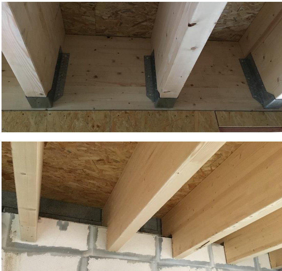
Figure 5 - Photos des solives en bois du plancher (En haut : fixation sur la muralière / En bas : en appui sur le mur en béton cellulaire situé dans le fond du local R)
