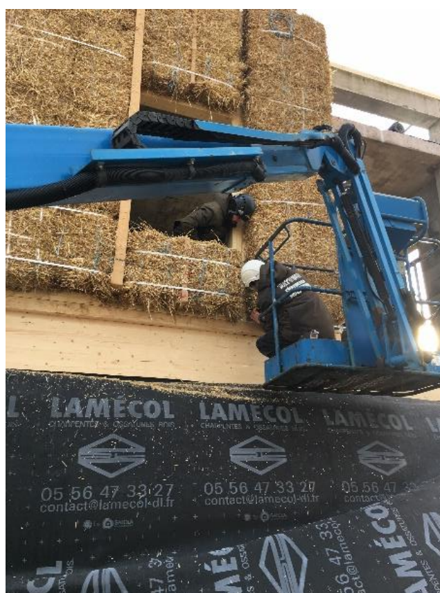
Figure 2 – Photos du panneau MOB 0-3 et de son installation
