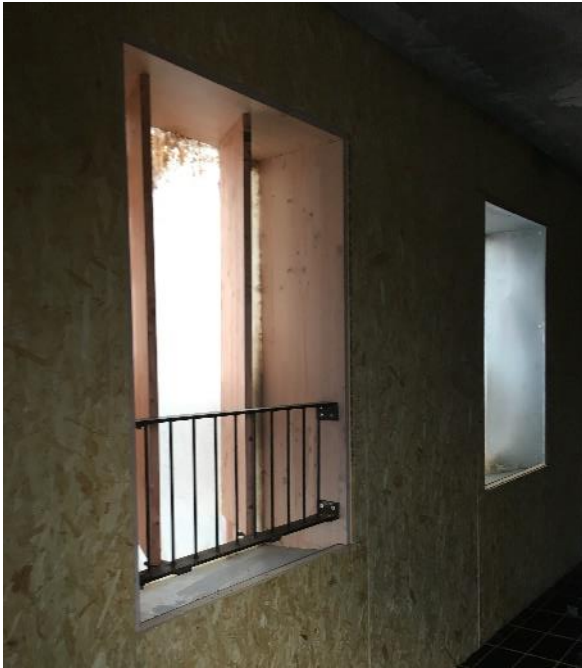
Figure 13 – Photos du garde-corps et des brise-soleils sur la Baie 2'
