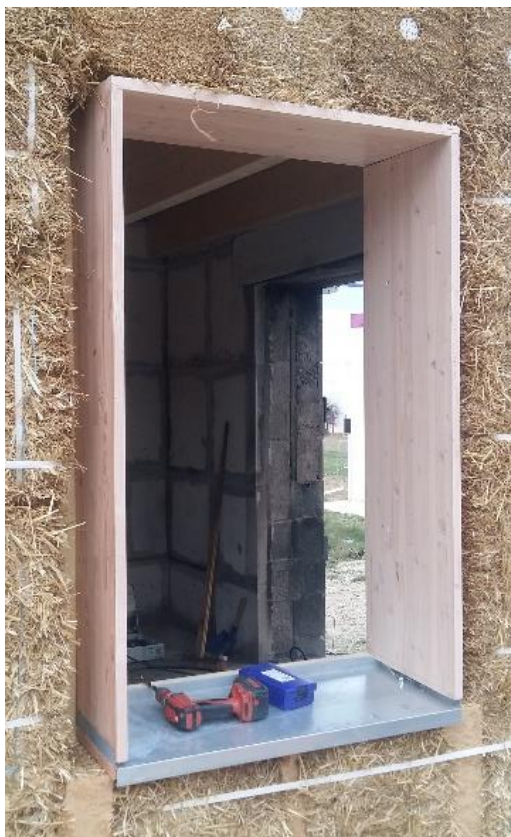
Figure 10 - Photos de l'installation des encadrements des Baies 1 et 2
