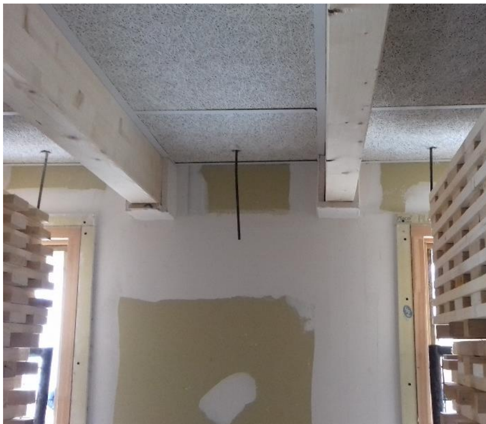
Figure 21 – Photo de la demi-cloison intérieure du local R, des encoffrements en périphérie des solives pour protéger les sabots de supportage des solives et des cadres en plaques de plâtre en périphérie des fenêtres des Bais 1 et 2
