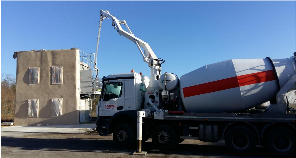
Figure 19 – Photo du coulage de la dalle béton
